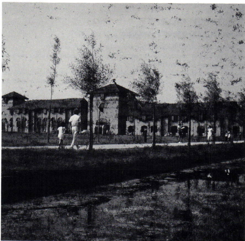
Herstellingsoord voor Zieken en Gehandicapten 'Ter Duinen', Nieuwpoort.
